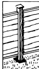
5. Der Schnellbeton ist hart und das Einbauteil steckt fest. Für den Einsatz in einem durchlässigen Boden wird empfohlen, das Loch zuerst halb mit Schnellbetonmörtel zu füllen dann Wasser dazu geben und leicht mischen.
