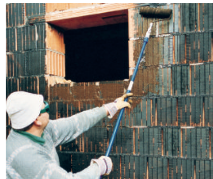
PCI Pecimor F, 1 : 5 mit Wasser verdünnt, als Grundierung für eine Bauwerksabdichtung mit kunststoffmodifizierter Bitumendickbeschichtung nach DIN 18 533.
