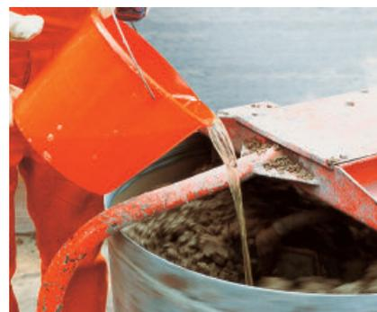
Nach Zugabe von PCI Estrifix in das Anmachwasser wird dieses in der benötigten Menge je nach gewünschter Konsistenz des Estrichmörtels in den Mischbehälter gegeben.
