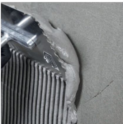
PCI Barraseal Turbo muss in mindestens 2 Abdichtungslagen aufgebracht werden. Zur Kontrolle der Schichtdicke kann das Material aufgezehnt und dann abgeglättet werden.
