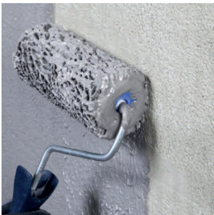
Aufbringen einer Kontaktschicht mit dem Roller.
