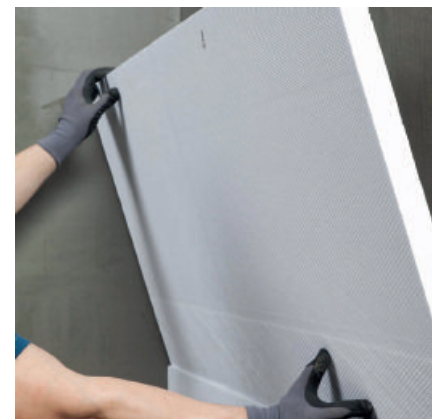
Mit PCI Barraseal Turbo können auf den erhärteten Untergrund Drain- und Dämmplatten geklebt werden.
