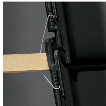
Die Fixierungskerben für die Sturmklammern.
