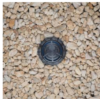
Gully mit Kiesfang im Flachdach
